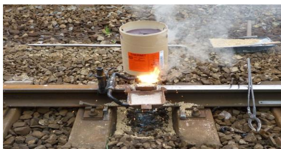
Рисунок 1 – Алюминотермитная сварка рельсов
